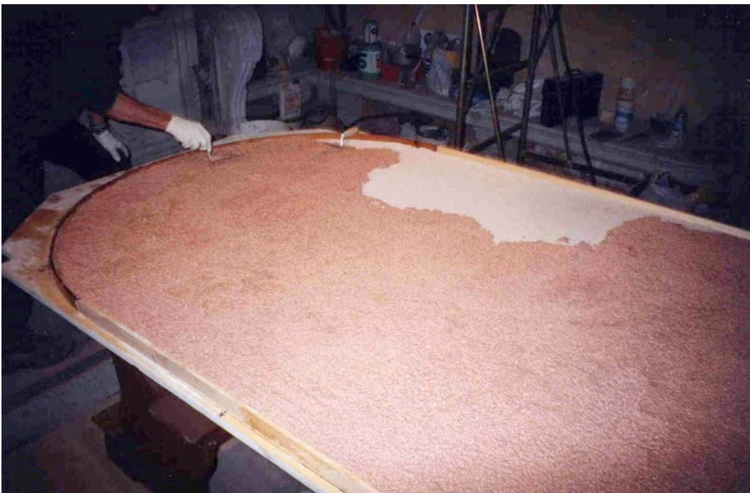
Ancora sopra si è adagiato un pannello in vetro resina con struttura alveolare in alluminio di 1,4 cm. di spessore, sul quale precedentemente si era stesa, con resina epossidica, una graniglia di cotto per ottenere un miglior aggrappaggio.
