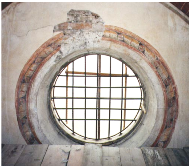
Foto – Particolare del tondo finestra prima del restauro.
