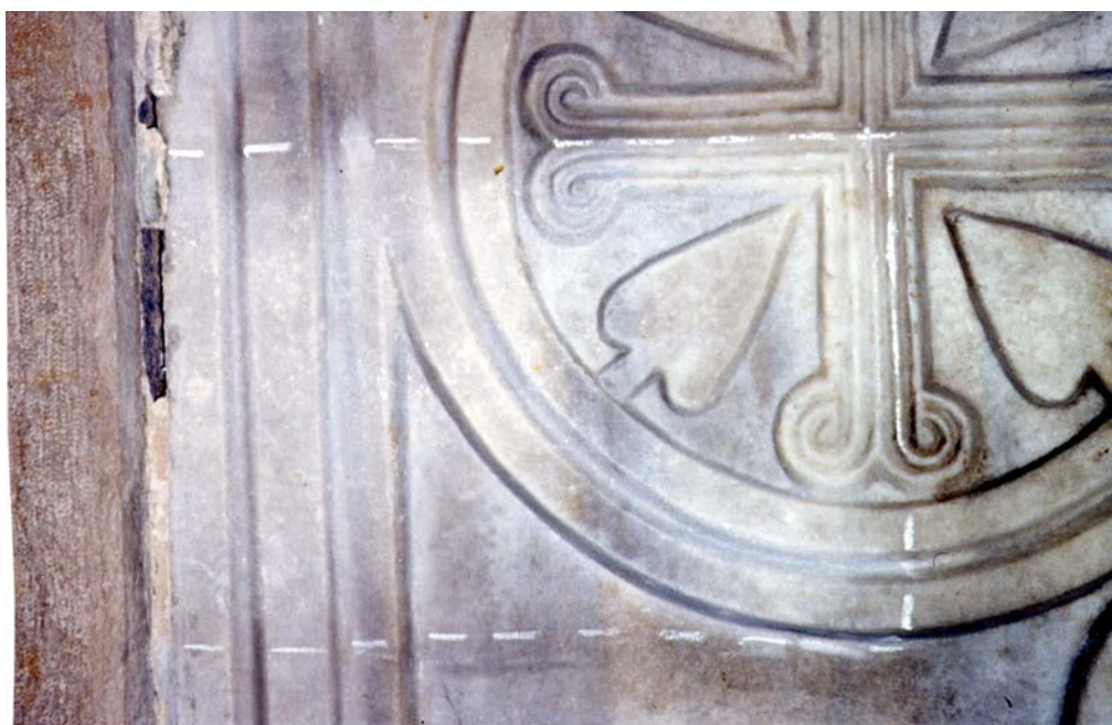
Foto – Prova di pulitura.
